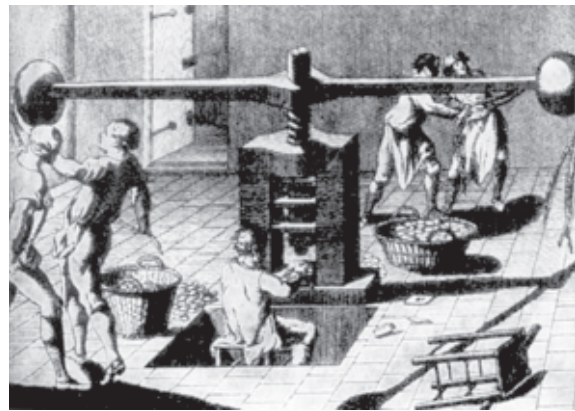
Карбувальний прес часів І. Ньютон
