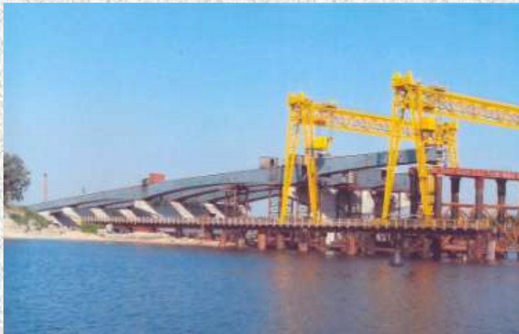
Мостовой перехід, м. Київ Bridge passage, Kyiv
